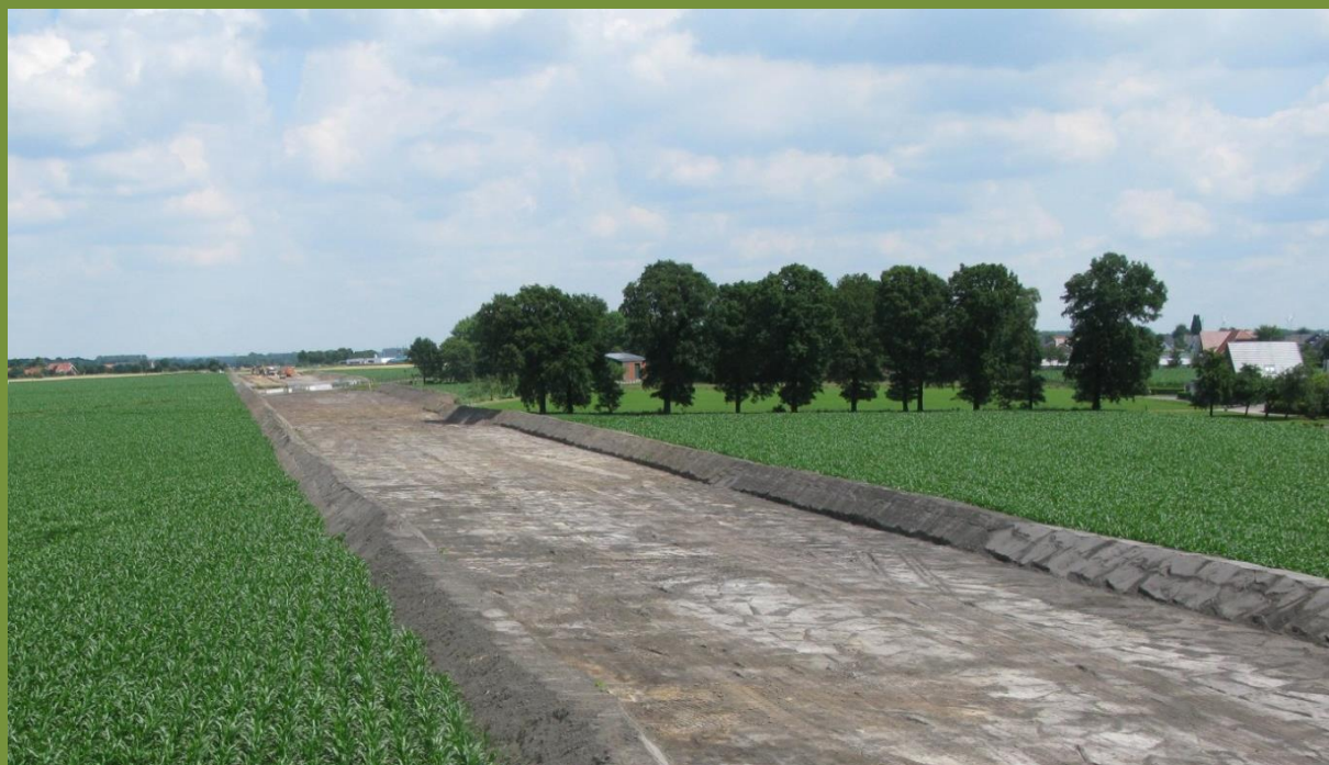
Rund 40 m breite Baubedarfsfläche einer 380 kV- Wechselstrom- Kabeltrasse nach Oberbodenabtrag auf Ackerland.
